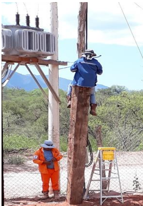
Anexo N°19 Trabajando de forma insegura en instalaciones de luz.
