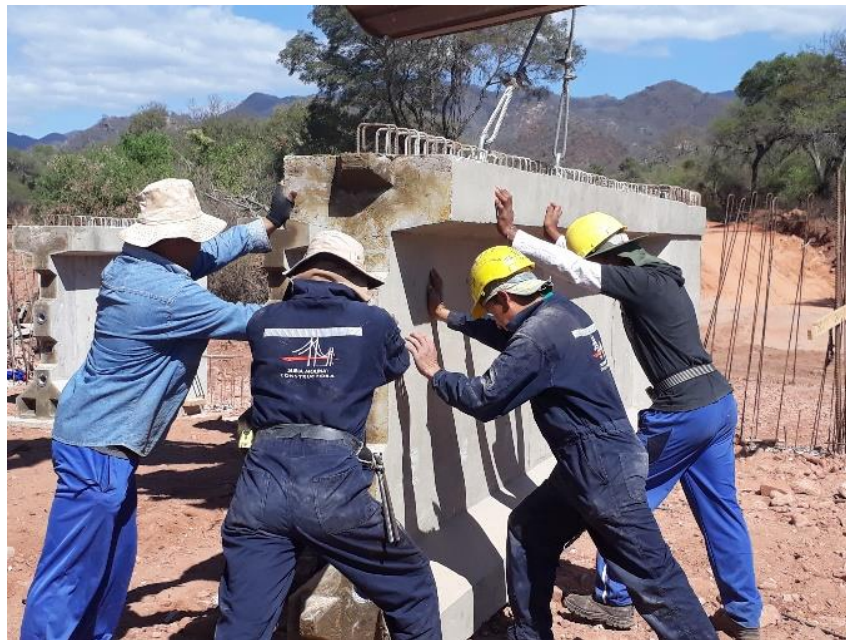
Anexo N°28 Trabajadores sin equipo de protección personal moviendo un muro de hormigón armado.
