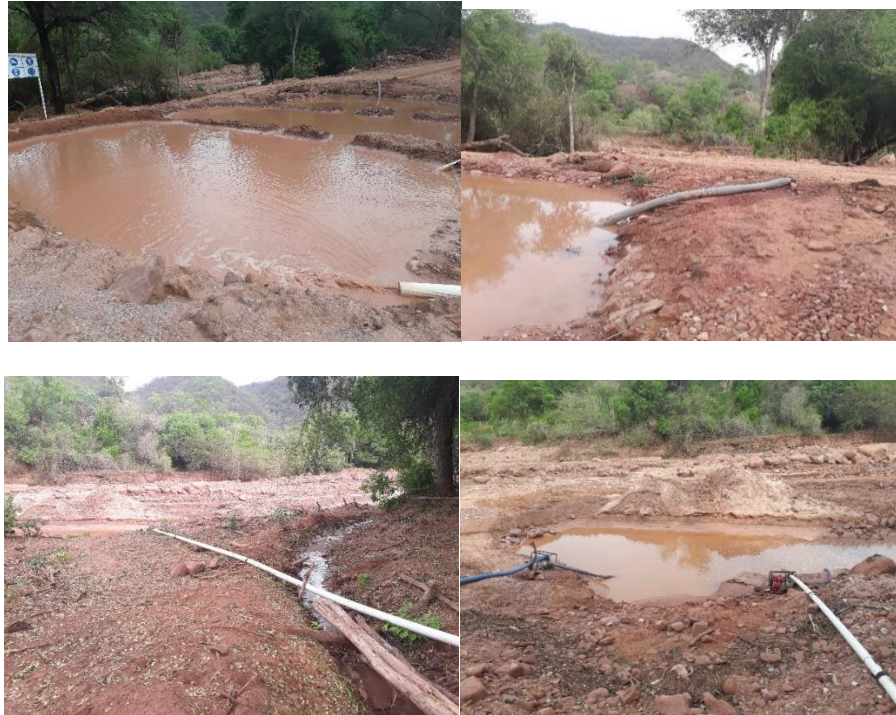
Fotografía N° 1 Fosas de sedimentación de la planta de tratamiento de áridos Chimeo.
