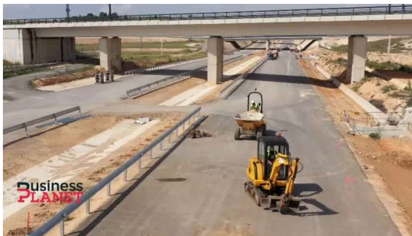
Figura 2.14: Carretera en España construida con cenizas de papel
