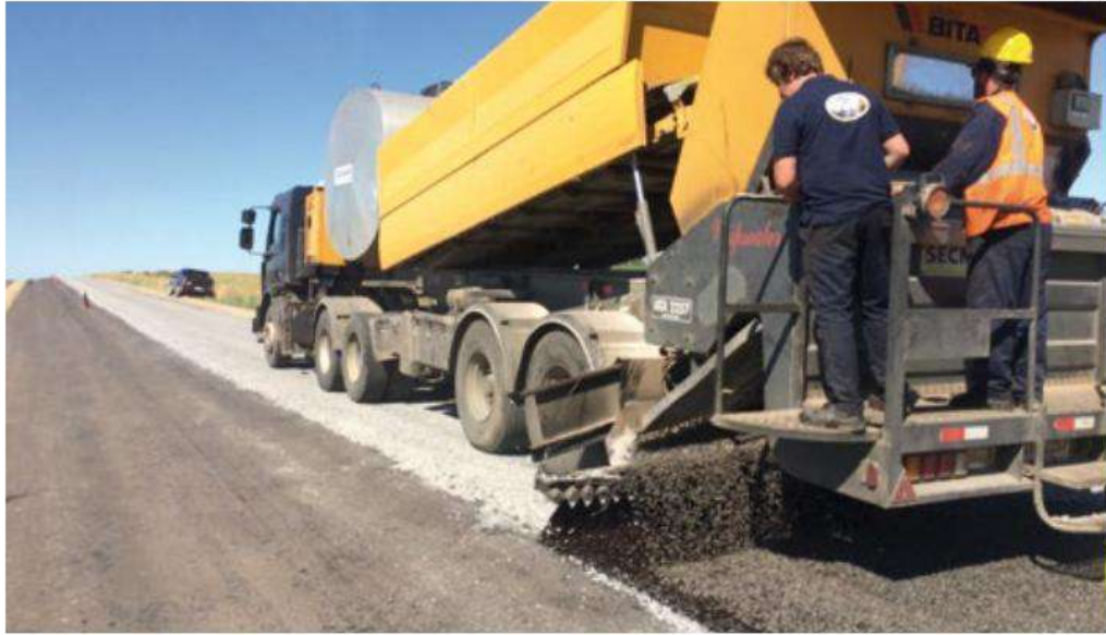
Figura 2.12: Tratamiento doble sobre base granular imprimada en Ruta 57, año 2017.
