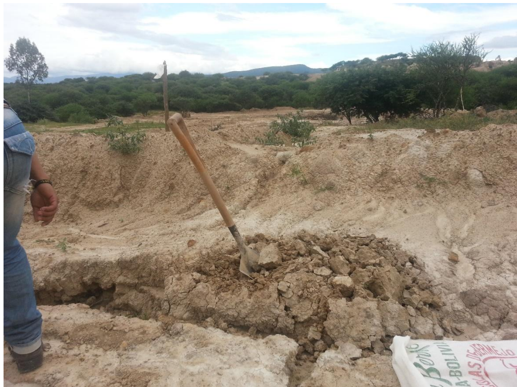
Extracción de muestras de suelo para clasificación y trabajo de gabinete.
