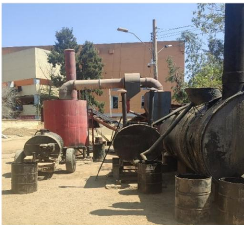
Figura 3.3. Ubicación de la planta de asfalto de la alcaldía de Tarija
