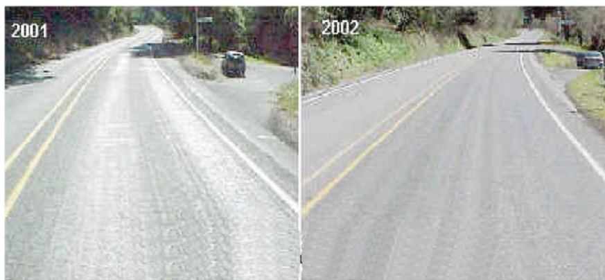
Figura 2.3. Carretera antes y después de un tratamiento superficial
