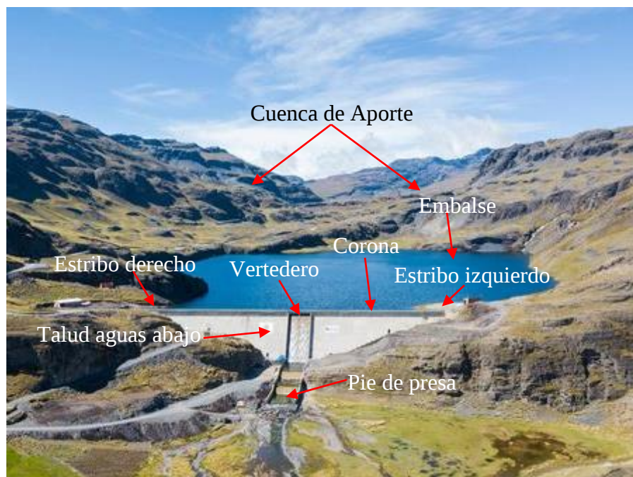
Figura 2.10: Partes de una presa más el embalse y su cuenca.
