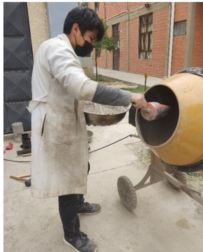
Fotografía 18. Mezclado de componentes del mortero
