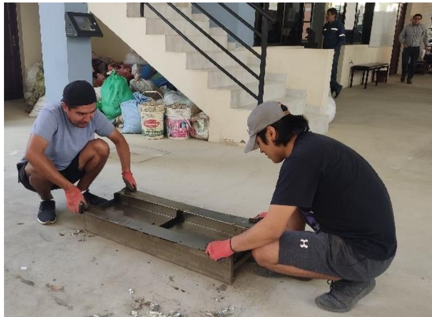
Fotografia 35. Desencofrado de viga
