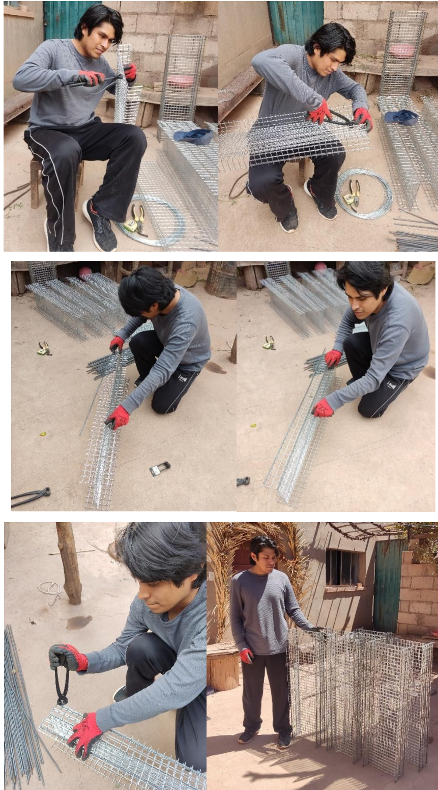
Fotografía 30. Armado del sistema de refuerzo en forma de I
