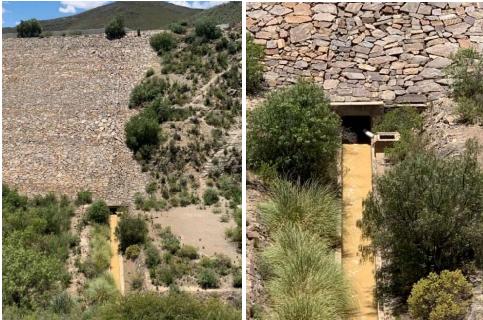
Figura 4.9: Canal de obra de toma de la represa El Tranque Fuente: Elaboración propia.
