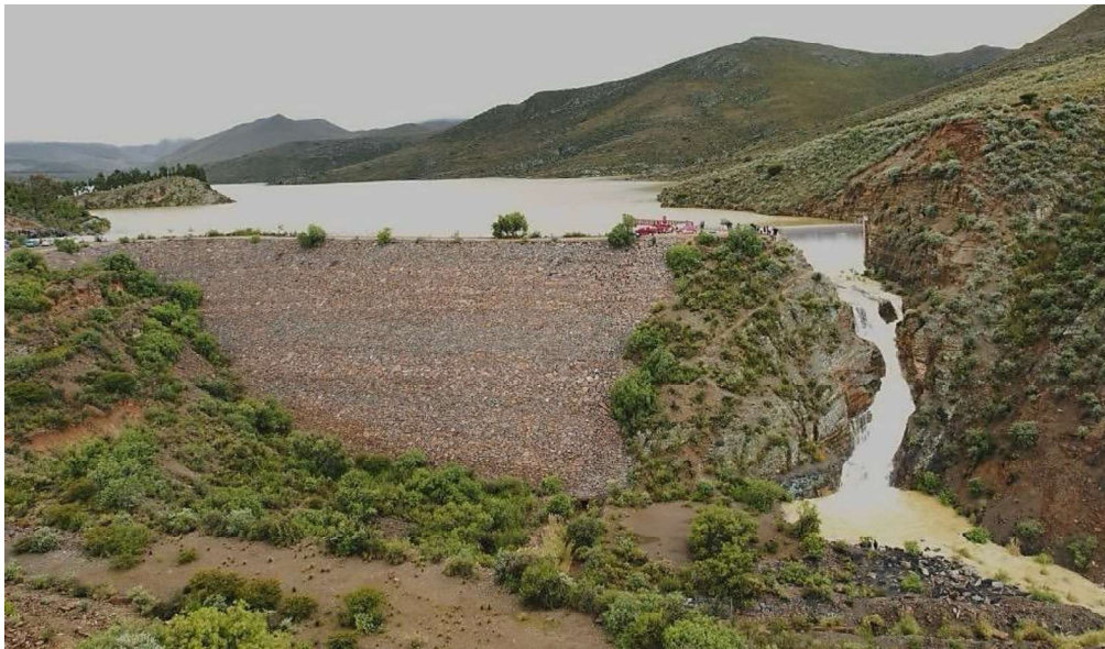
Figura 4.10: Vertedero de excedencias dirigiendo sus aguas al río Culpina Fuente: De los Cintis, 2017.
