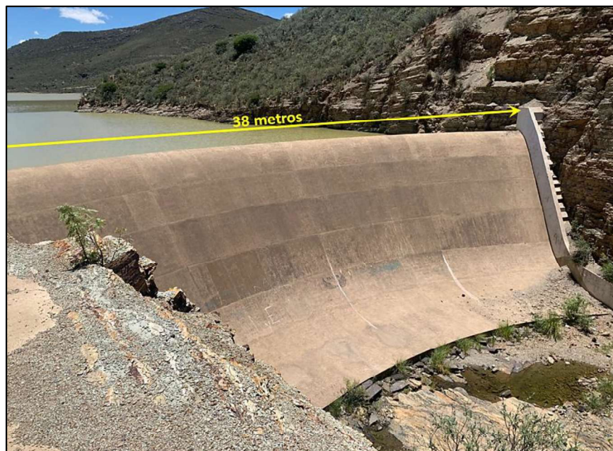
Figura 4.6: Vertedero de la represa El Tranque Fuente: Elaboración propia.
