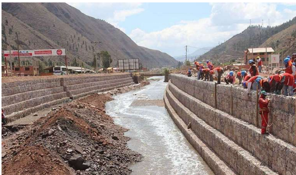
Figura 5.55: Vista en obra del encauzamiento con muros de gaviones
