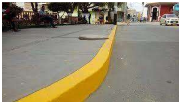
Figura N° 95 Pintura terminada en zona rígida
