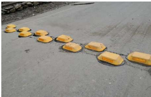
Figura N° 100 Colocado de tachones disipadores de velocidad
