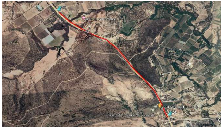
Figura N° 77 Tramo punto 23 – punto 24
