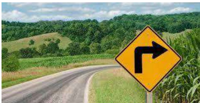
Figura N° 103 Instalación de señal preventiva
