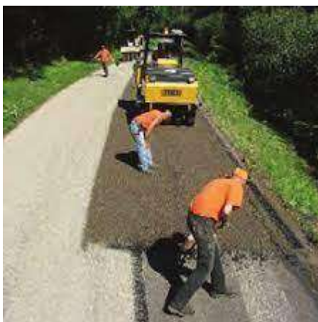
Figura N° 107 Tratamiento superficial con mezcla asfáltica en caliente
