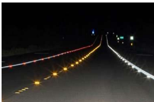
Figura N° 101 Colocado de tachones direccionales
