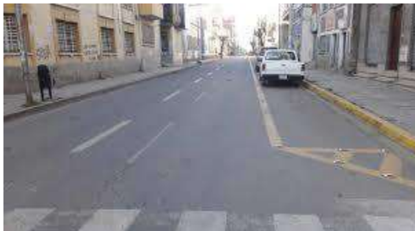
Figura N° 96 Pintura terminada en zona de estacionamiento
