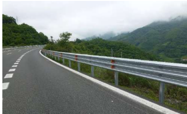
Figura N° 108 Barandas de defensa
