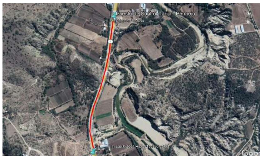
Figura N° 83 Tramo puesto control Tarija - Bermejo
