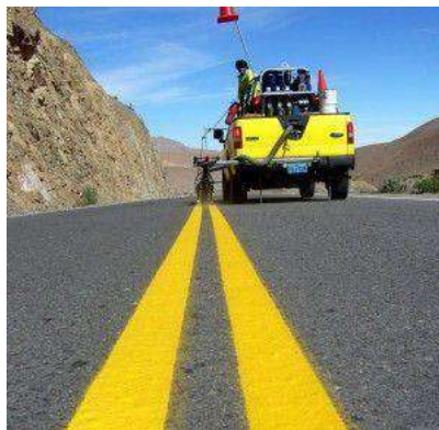
Figura N° 97 Pintado de doble línea continua divisora de carril
