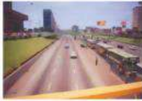
Figura N° 4 Nivel de Servicio A
