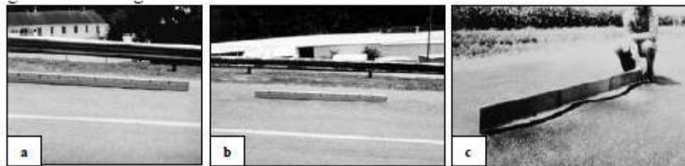
Figura N° 12 Corrugación
