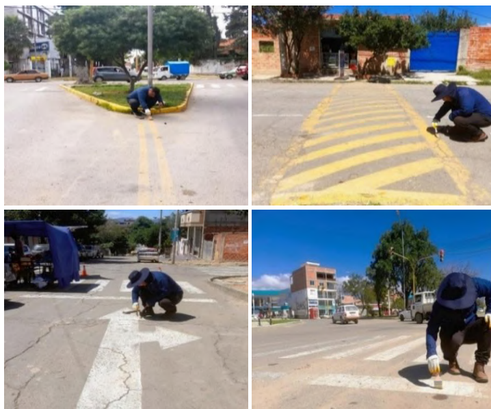
Figura 3. 17 Limpieza de la superficie de las demarcaciones viales
