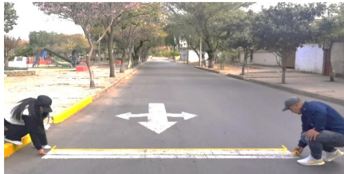
Figura 3. 13 Medición de líneas de detención
