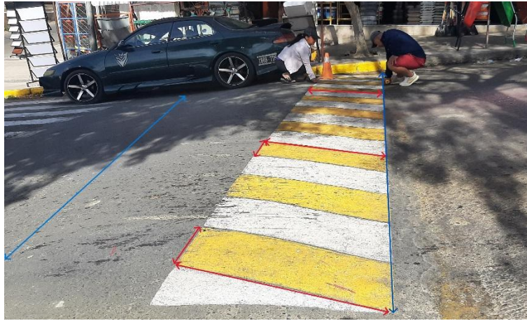
Figura 3. 11 Medición de resaltos o reductores de velocidad
