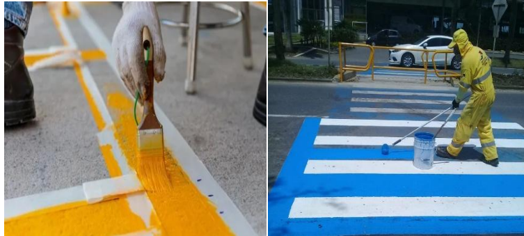
Figura 2. 1 Pintado de la demarcación con brocha y rodillo
