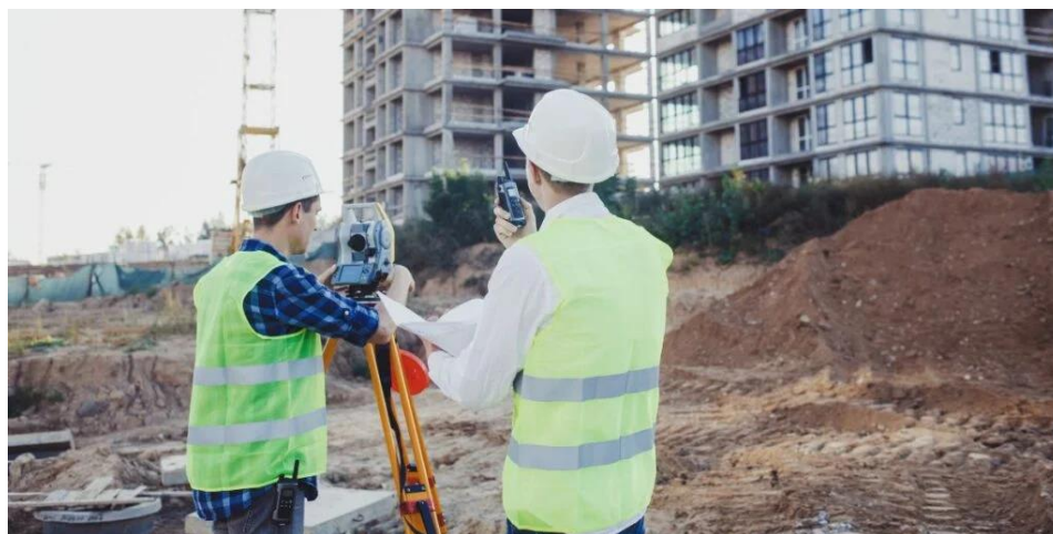
Figura 2.4 Replanteo con estación total
