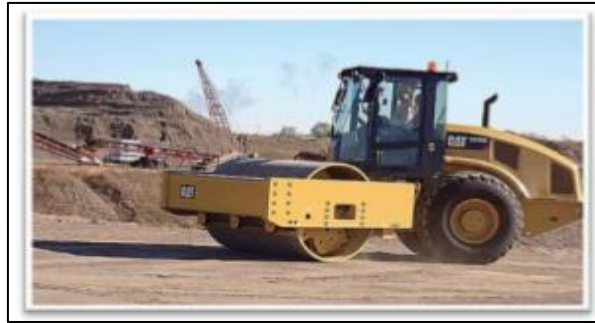
Figura 2.12: Compactación del suelo
