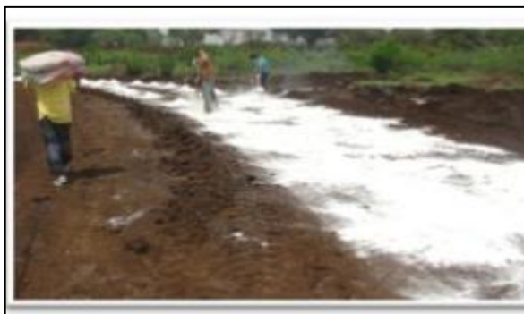
Figura 2.14: Compactación química del suelo
