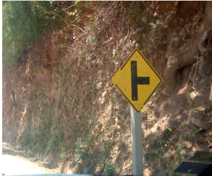
Figura N° 4.23 Señal preventiva vía lateral derecha TCA 4
