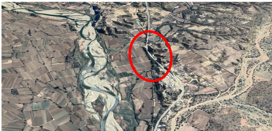
Figura N° 4.14 Vista aérea TCA 3
