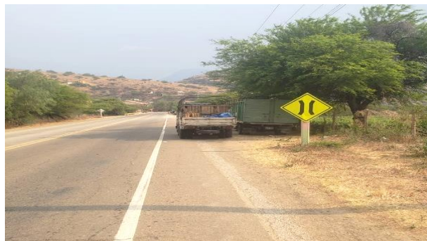
Figura N° 4.17 Informativa Puente después de la curva y en pendiente TCA 3
