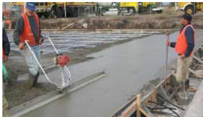
Figura 1.2. Losa de concreto vibrado
