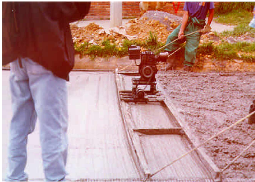
Figura 1.12. Viga terminadora
