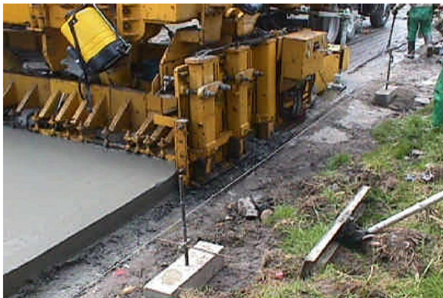
Figura 1.9. Conformación de la losa
