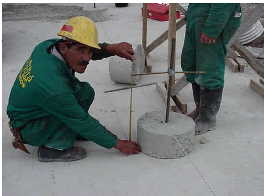
Figura 1.10. Colocación del hilo guía
