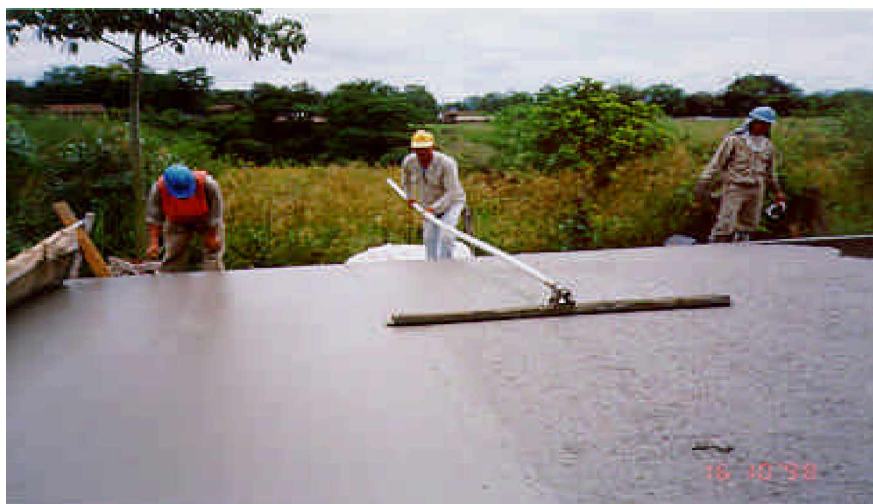
Figura 1.13. Flotado de la Superficie del Pavimento
