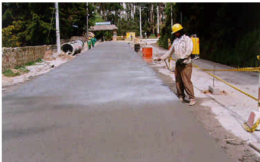
Figura 1.16. Curado de la Superficie del pavimento mediante riego
