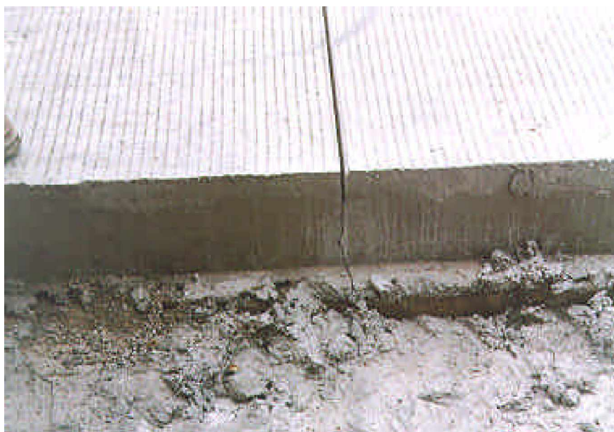
Figura 1.18. Junta por serrado
