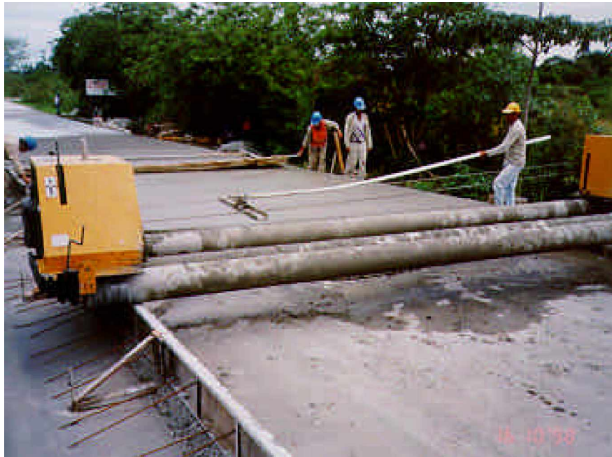
Figura 1.6. Rodillo Vibratorio de dos motores
