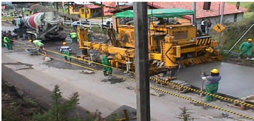
Figura 1.8. Conformación de la losa
