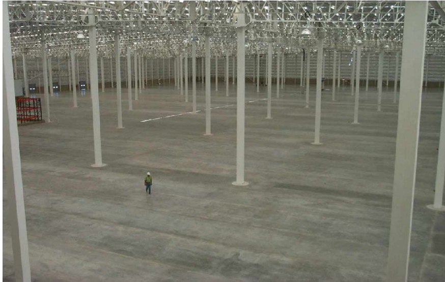
Figura 1.4. Centro de Distribución Nestlé (Losa Postensada)
