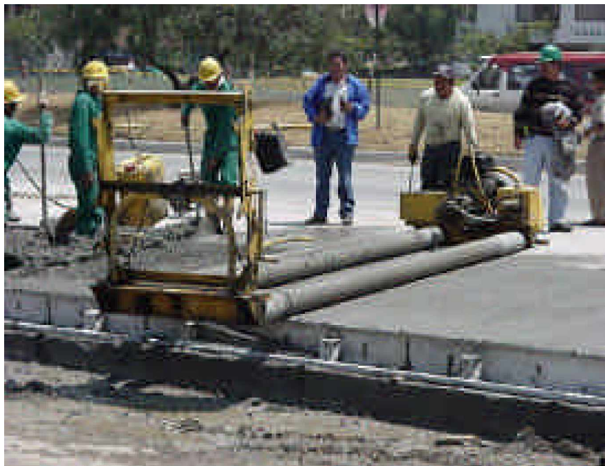
Figura 1.5. Rodillo Vibratorio de un motor
