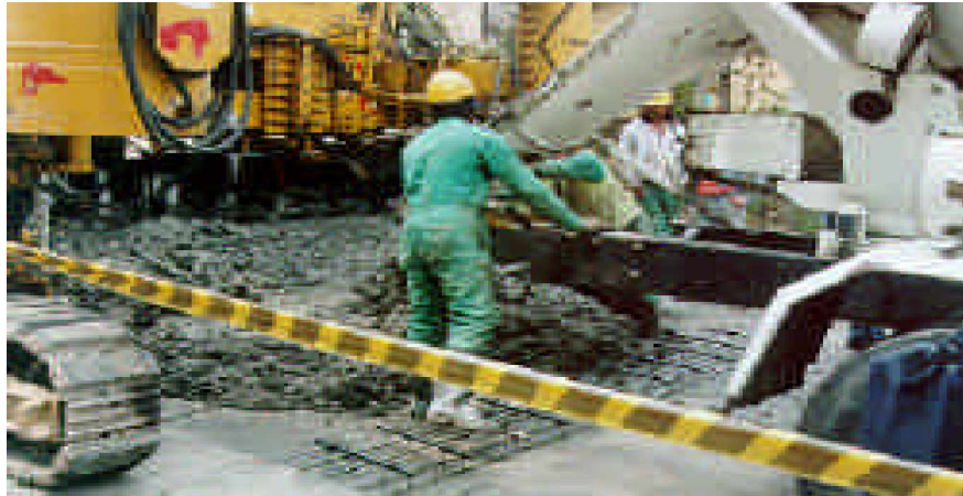
Figura 1.7. Descarga del camión a la extendidora
