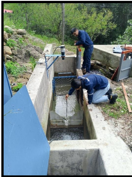
Figura 22 Medición de la lámina de agua que pasa por la cresta del vertedero.
