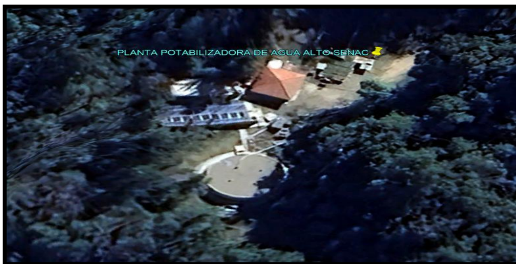
Figura 4 Ubicación de la Planta Potabilizadora Alto SENAC.
