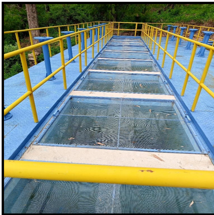
Figura 11 Batería de filtros.
