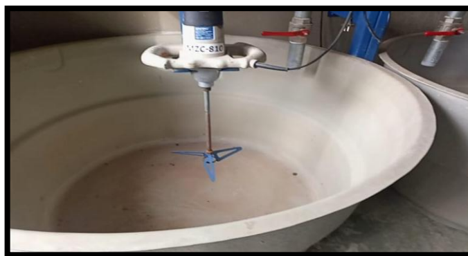
Figura 9 Tanque de la mezcla rápida y agitador mecánico.
