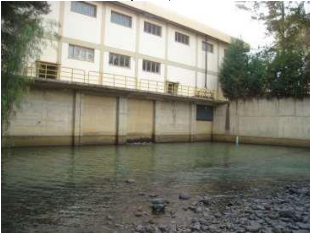
Figura 39: Canal de restitución. Fuente: Proyecto Múltiple San Jacinto.
