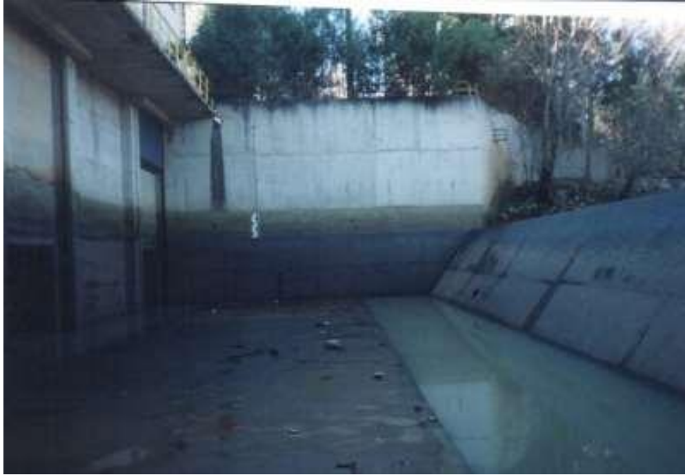
Figura 38: Canal de desagüe. Fuente: Proyecto Múltiple San Jacinto.
