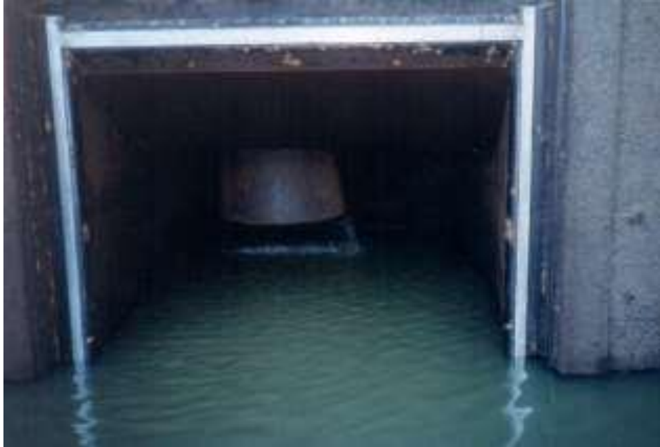
Figura 36: Tubo de Aspiración. Fuente: Proyecto Múltiple San Jacinto.
