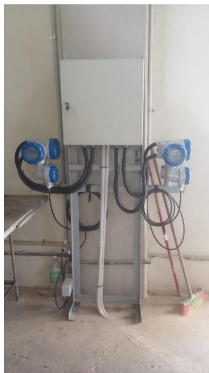
Figura 30: Instalación del Caudalímetro.
