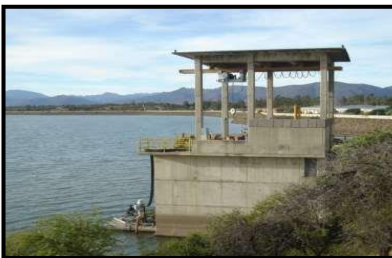
Figura 24: Obra de toma. Fuente: Fotografía del autor.
