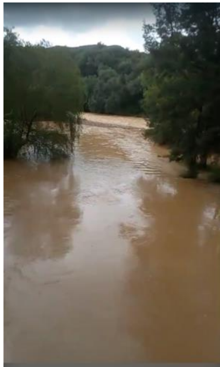
Figura 37: Canal de salida del agua. Fuente:” Central Hidroeléctrica San Jacinto “Fotografía del autor.
