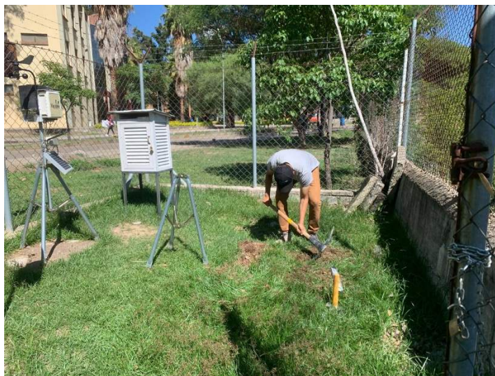
Figura 4.2 Instalación y anclaje de pluviómetros
