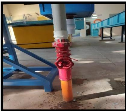
Figura 19: Válvula tipo compuerta.
