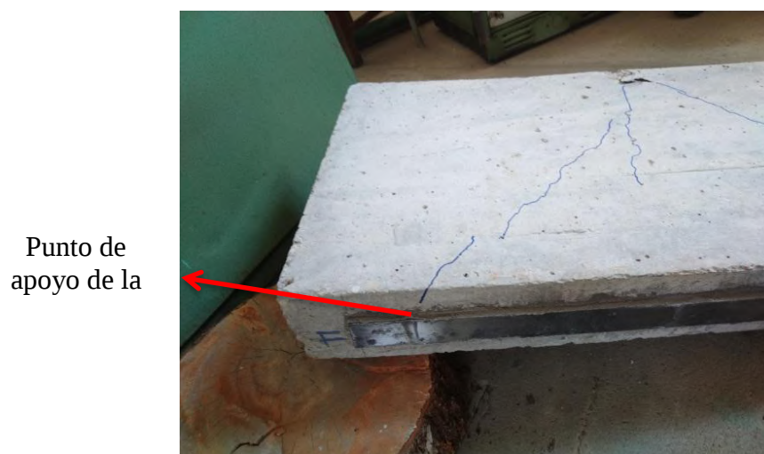
Figura 4.23 Fisuras por fallo a cortante
