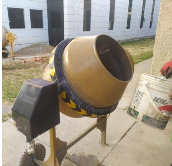
Figura 3.43 Vaciado de los componentes a la mezcladora
