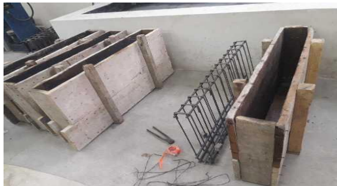
Figura 3.60 Armadura y encofrado de madera
