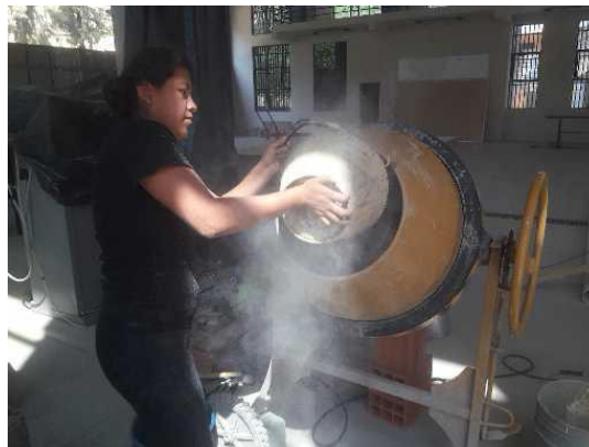
Figura 3.60 Vaciado de vigas
