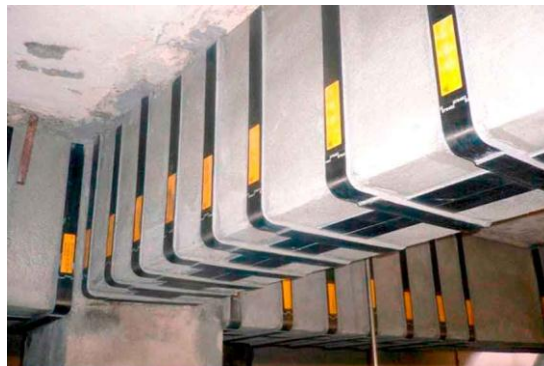
Figura 2.25 Platinas encoladas en vigas
