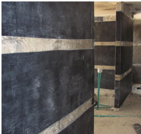
Figura 2.17 Refuerzo estructural de corte con tejidos de CFRP en muros
