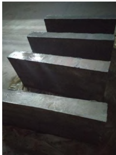
Figura 3.60 Vigas en etapa de curación
