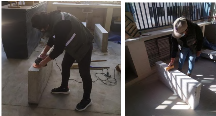
Figura 3.60 Uso de amoladora y lija para pulir
