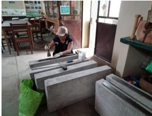
Figura 3.69 Pegado de la fibra en todas las vigas
