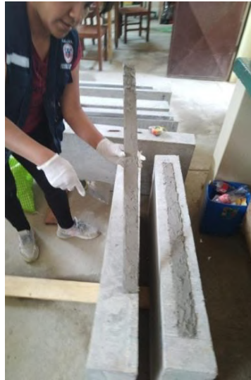
Figura 3.67 Colocado del pegamento en la lámina
