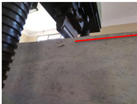
Figura 4.19 Fallo a compresión en cabeza superior de la viga
