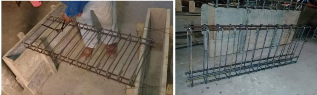
Figura 3.60 Entramado de la armadura pasiva
