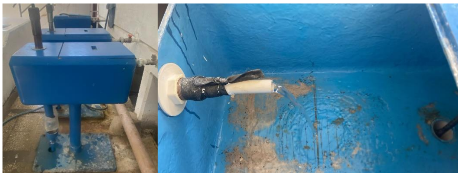
Figura 3-4. Ubicación de bomba dosificadora Grundfos DMX
