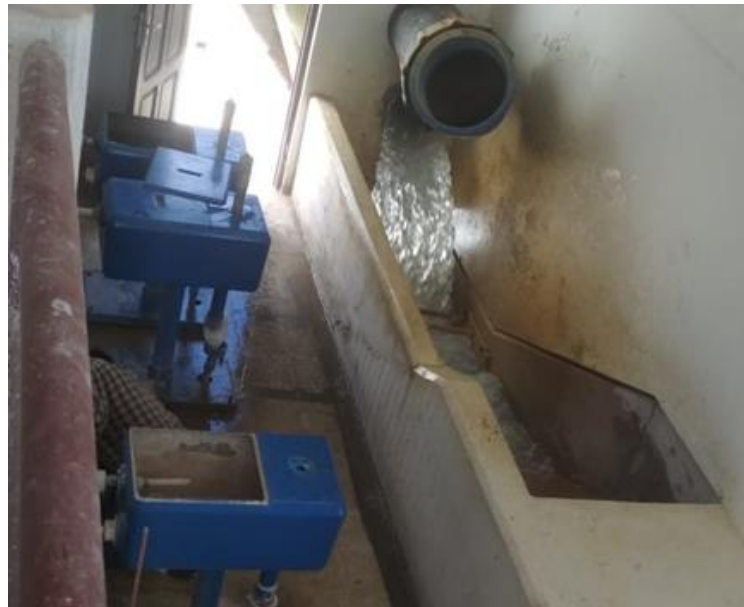
Figura 1-5. Unidad de Mezcla Rápida
