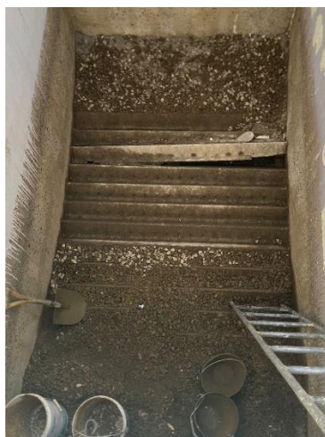
Vigueta dañada en filtros
