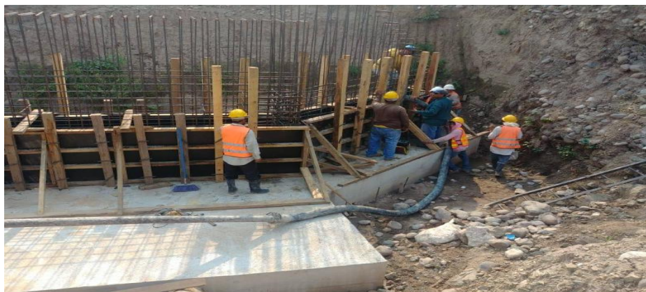
Figura 4.3. Cimentación de estribo
