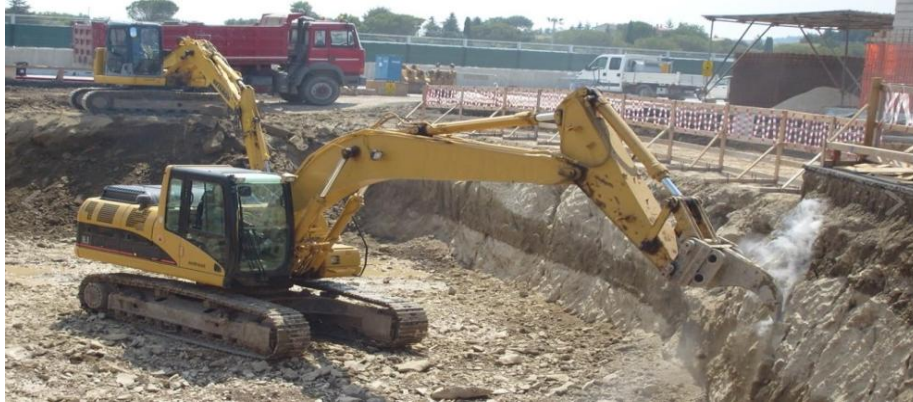
Figura 4.2. Excavación de cimientos
