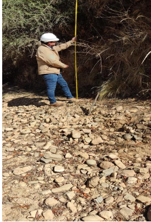
Sacando medidas para el emplazamiento del Puente
