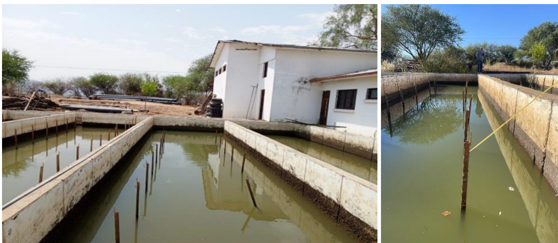
Figura 37. Unidad de Floculación con placas de madera.
