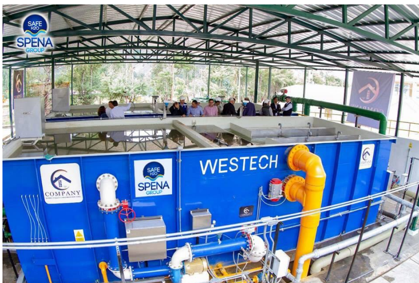
Figura 28. Planta de tratamiento de agua potable compacta Modelo Trident HS 2100
