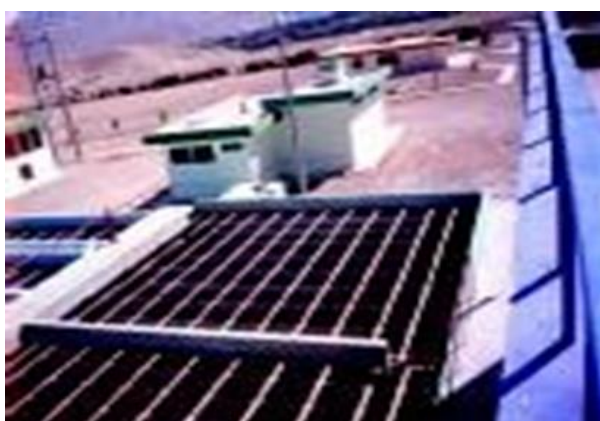
Figura 20. Floculador de pantallas de flujo horizontal
