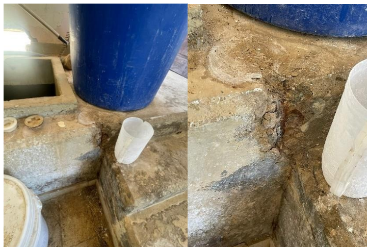
Figura 46. Fallas en el concreto.
