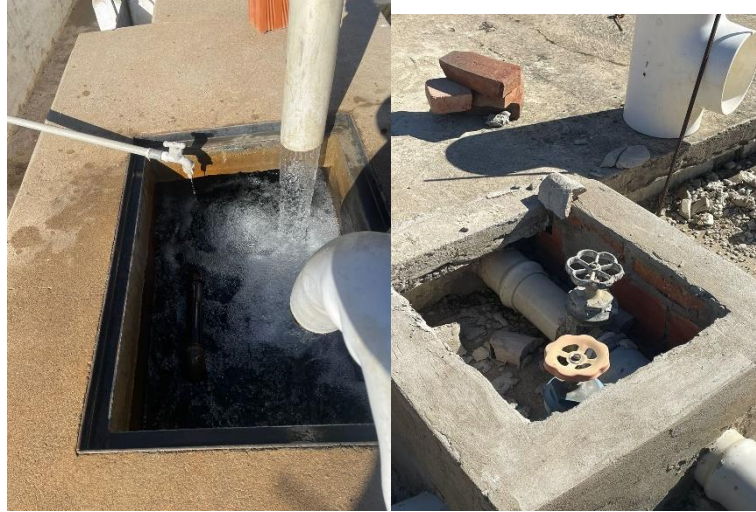
Figura 51. Despostillamientos en áreas de protección de accesorios.
