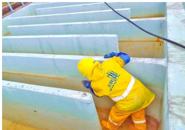
Figura 17. Mantenimiento de floculadores horizontales
