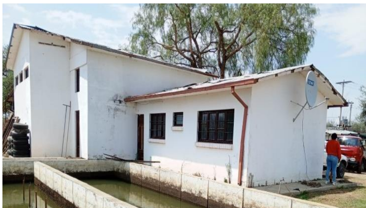
Figura 36. Unidad de laboratorio y mezcla rápida.
