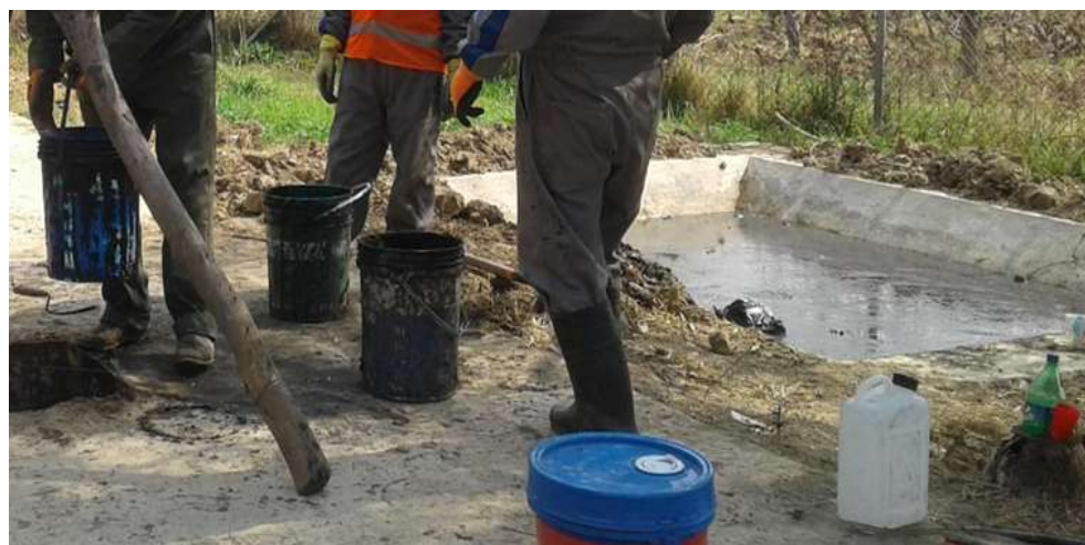
Figura 4. 10 Lecho de secado de la PTAR Calamuchita.
