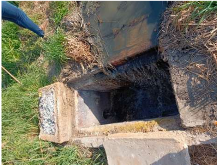
Figura 4. 8 Último componente a la salida de la PTAR (cámara de inspección).
