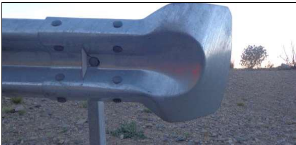
Figura 33: Pieza especial tipo aleta
