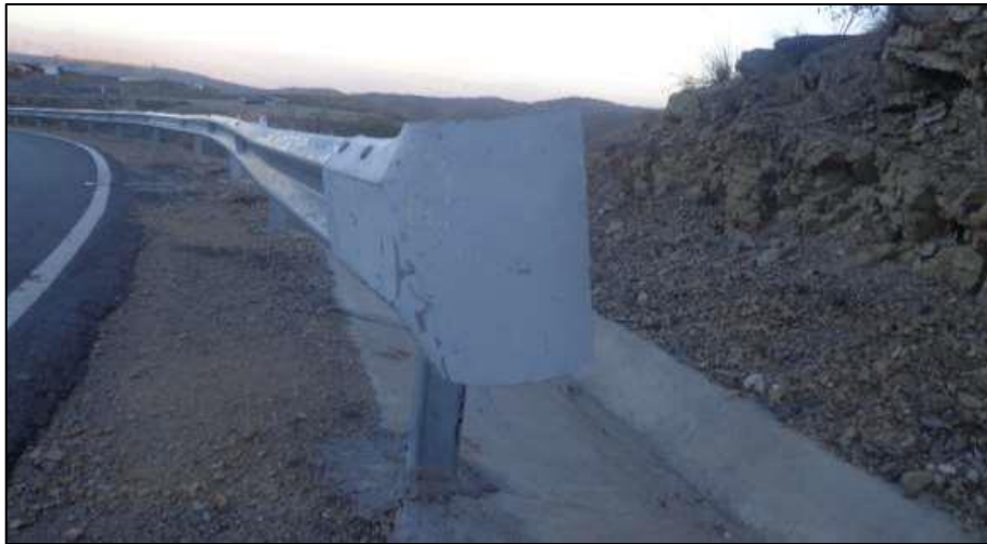
Figura 34: Pieza especial tipo cola de pez
