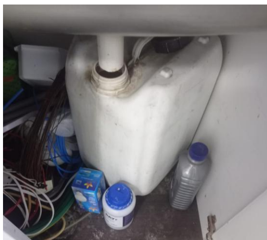
Figura 53 Bidón de 20 litros donde desembocan los desechos de líquidos de revelado de Rx
