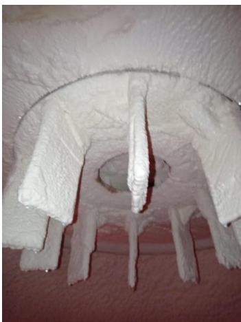
Figura 14 Estructura interna del reactor
