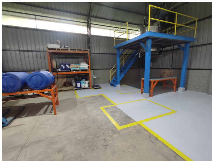
Figura 26.- Delimitación de áreas con pintura poliuretano amarilla.
