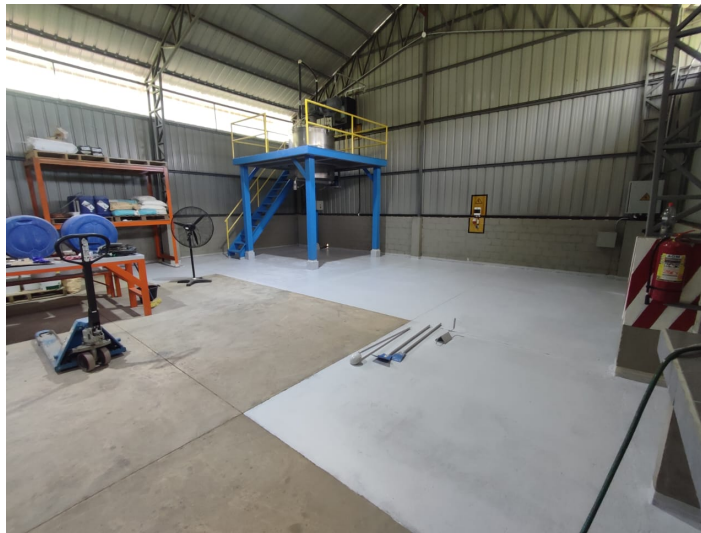
Figura 24.- Inicio de cobertura epoxica en área de producción.
