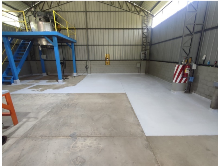
Figura 23.- Inicio de cobertura epoxica en área de producción.
