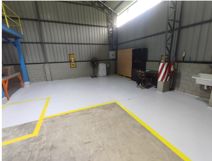
Figura 25.- Delimitación de áreas con pintura poliuretano amarilla.
