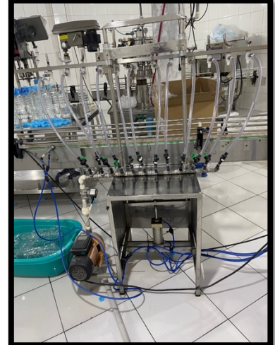
Sistema de llenado automático de agua
