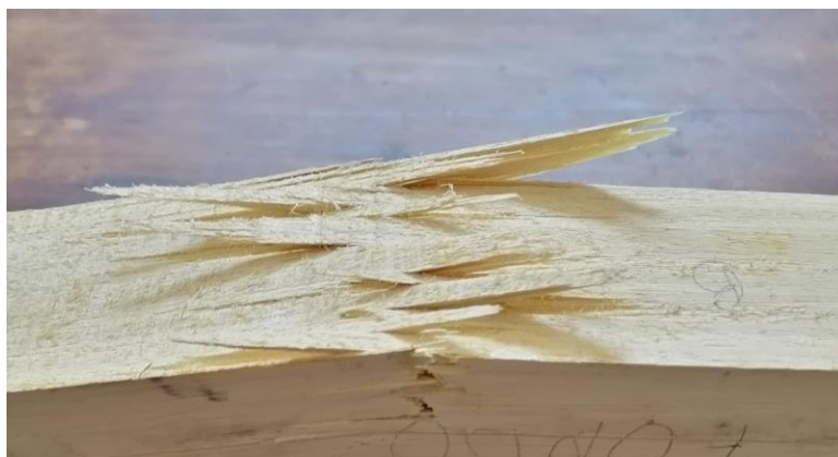
FOTO 6.- Falla en estado seco
