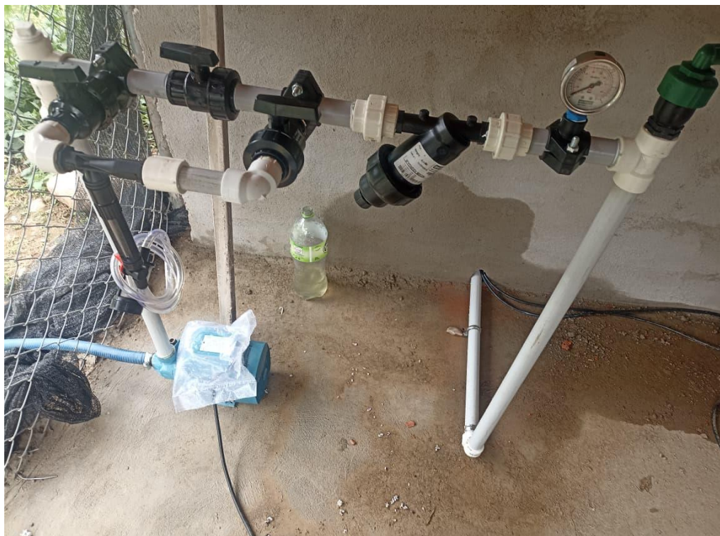
Cabezal de riego
