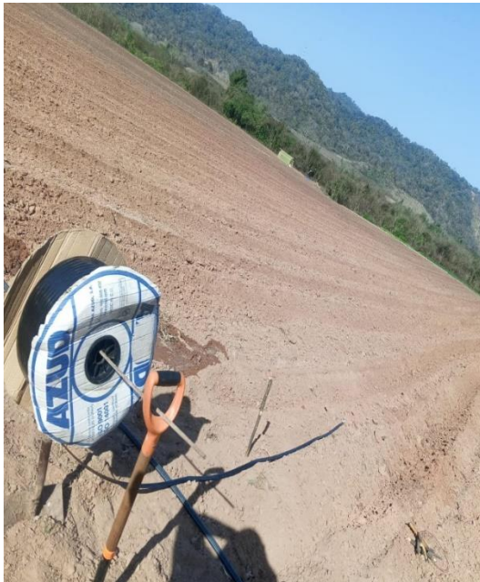
Instalación de cinta de riego a goteo
