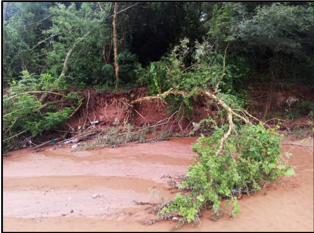
Figura 7. Evidencia de socavamiento lateral y desplome de vegetación inestable en la margen urbana (Barrio Chaqueño).
