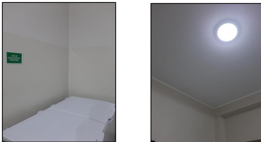
Figura IV - 7 Paredes y techo de la empresa
