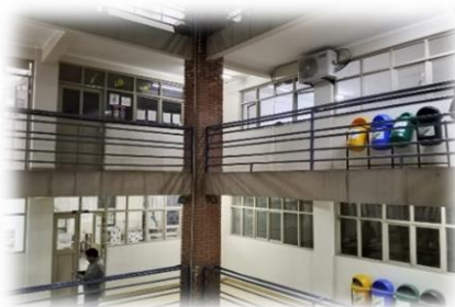
VISTA EXTERIOR DE AULAS
