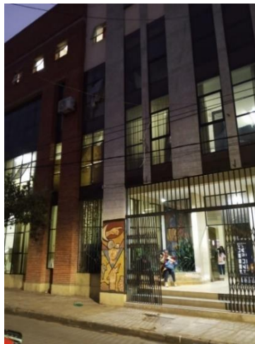
Ilustración 22. Edificio de Bellas artes
