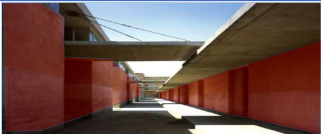
Figura 16: Formas de concreto “Centro de Invidentes y Débiles Visuales” México.
