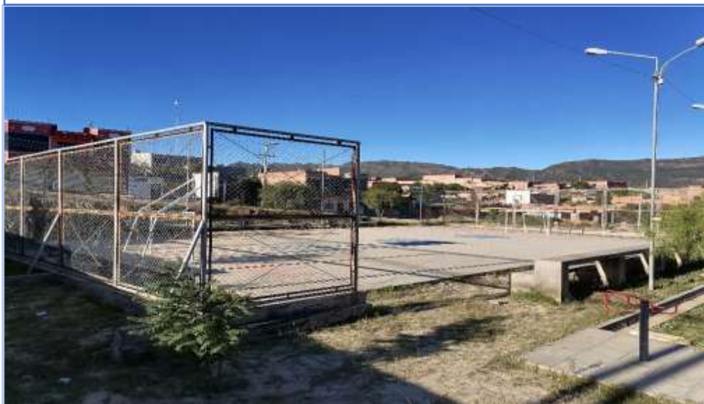
Figura 42: Equipamiento en el sitio – Cancha polifuncional
