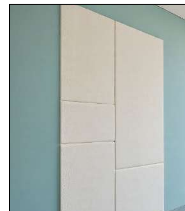
Figura 82: Revestimiento de espuma foam en paredes
