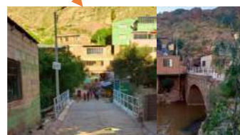
Imagen 30: Puente en la localidad de Miraflores
