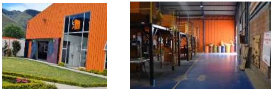
FIGURA 32: VISTA INTERIOR DE LA PLANTA DE RECICLAJE
