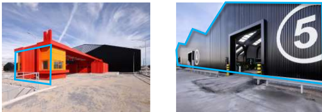
FIGURA 27: EXTERIOR DE LA PLANTA DE RECICLAJE
