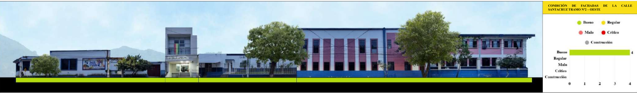
Figura N° 79 Condición de fachada de la calle santa cruz - oeste
