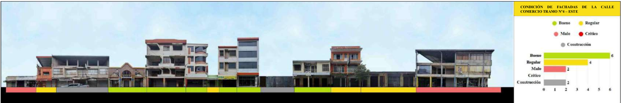
Figura N° 88 Condición de fachada de la calle comercio- este
