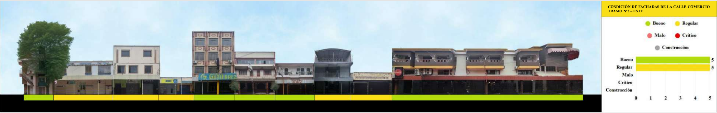
Figura N° 84 Condición de fachada de la calle comercio- este
