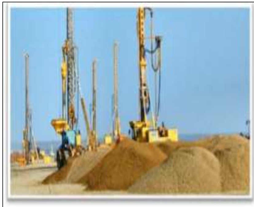
Gráfico N° 15. Estabilización de suelo mediante mezcla de suelos
