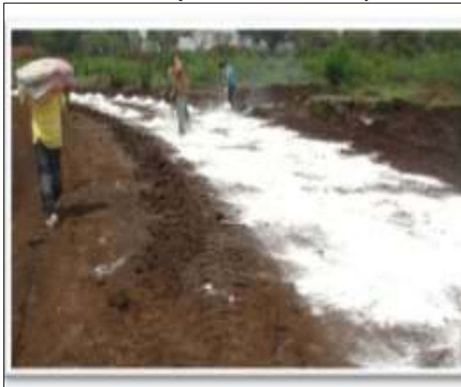
Gráfico N° 16. Compactación mediante aditivos químicos
