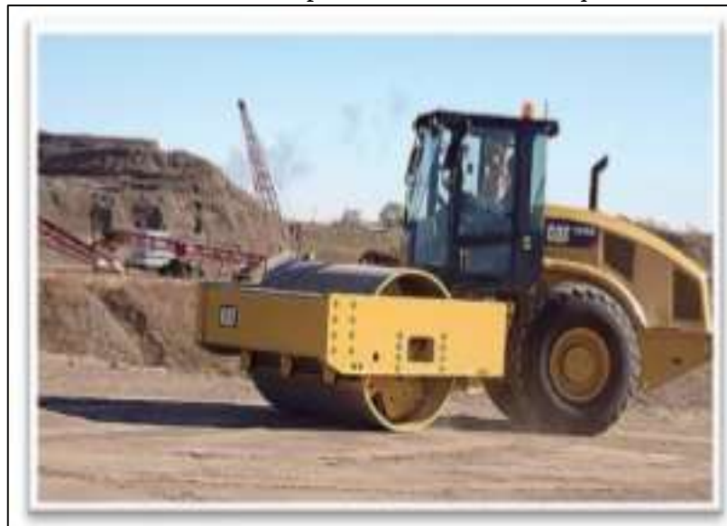
Gráfico N° 14. Compactación mediante maquinaria
