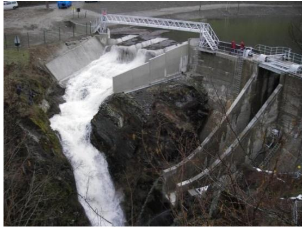
Figura 2.14 Vertedero PKW de presa Goulours en Francia
