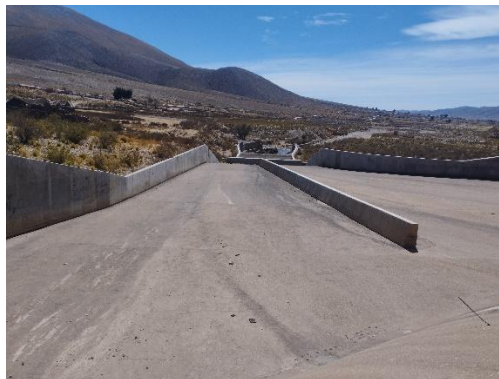
Figura 3.8 Muro en transición
