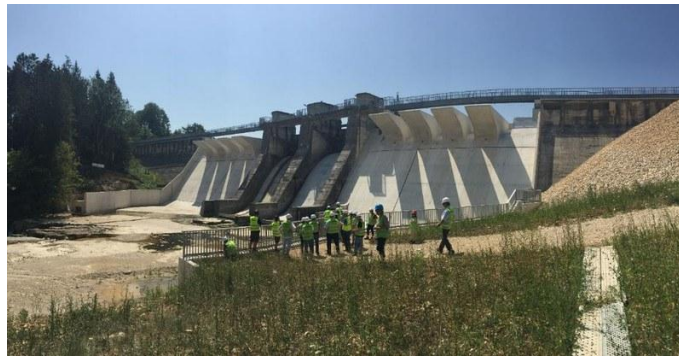
Figura 2.15 Vertedero PKW de presa Charmines en Francia
