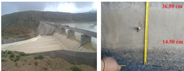
Figura 3.3 Aliviadero durante una crecida y huellas históricas
