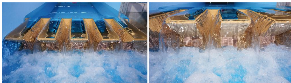
Figura 2.12 Vertedero PKW bajo operación hidráulica
