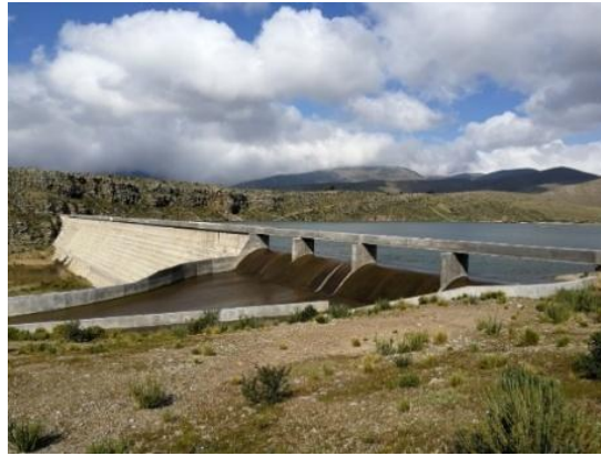
Figura 2.3 Embocadura recta, presa El Molino, Tarija-Bolivia
