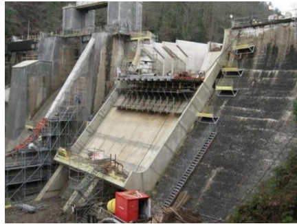
Figura 2.17 Vertedero PKW de presa Etroit en Francia
