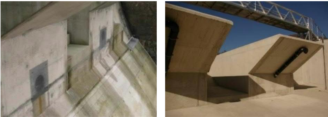
Figura 2.29 Red de aireación en Saint Marc (izquierda) y Goulours (derecha)
