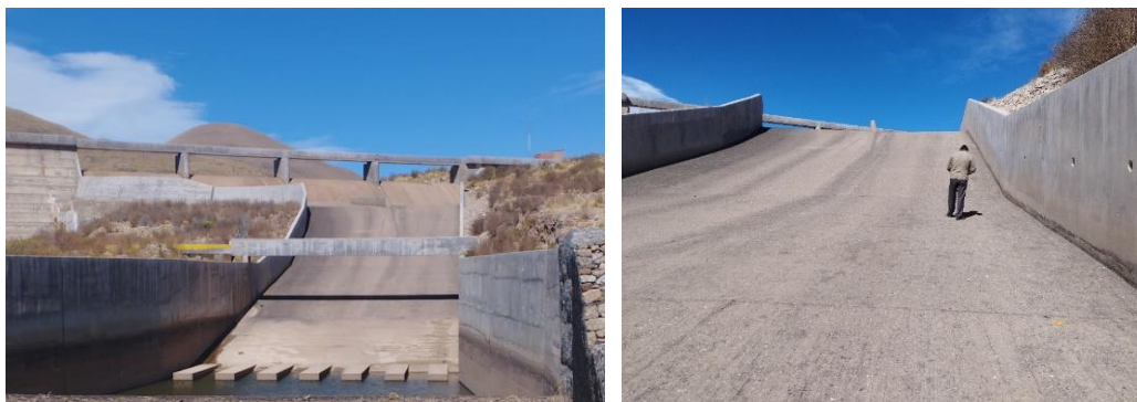
Figura 3.9 Rápida del aliviadero de la presa El Molino
