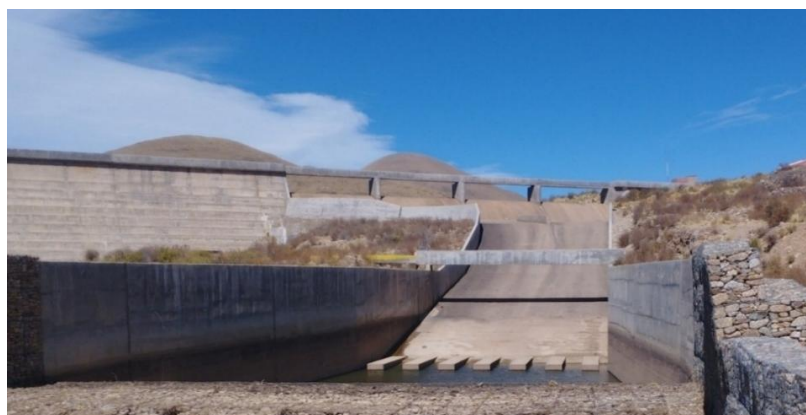
Figura 3.5 Aliviadero de la presa El Molino
