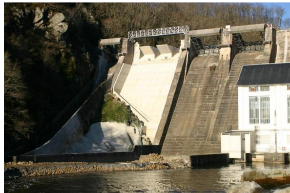
Figura 2.16 Vertedero PKW de presa Saint-Marc en Francia
