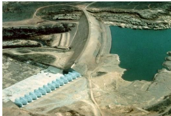
Figura 2.4 Embocadura de laberinto, presa Ute en New México
