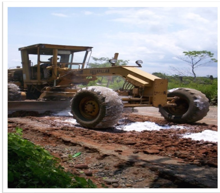
Figura 17. Estabilización de suelos
