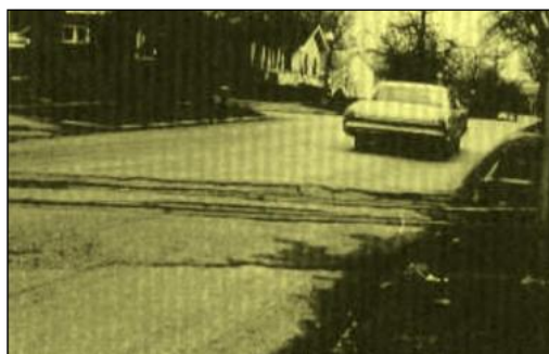
Figura N° 45.- Cruce de vía férrea de severidad alta.
