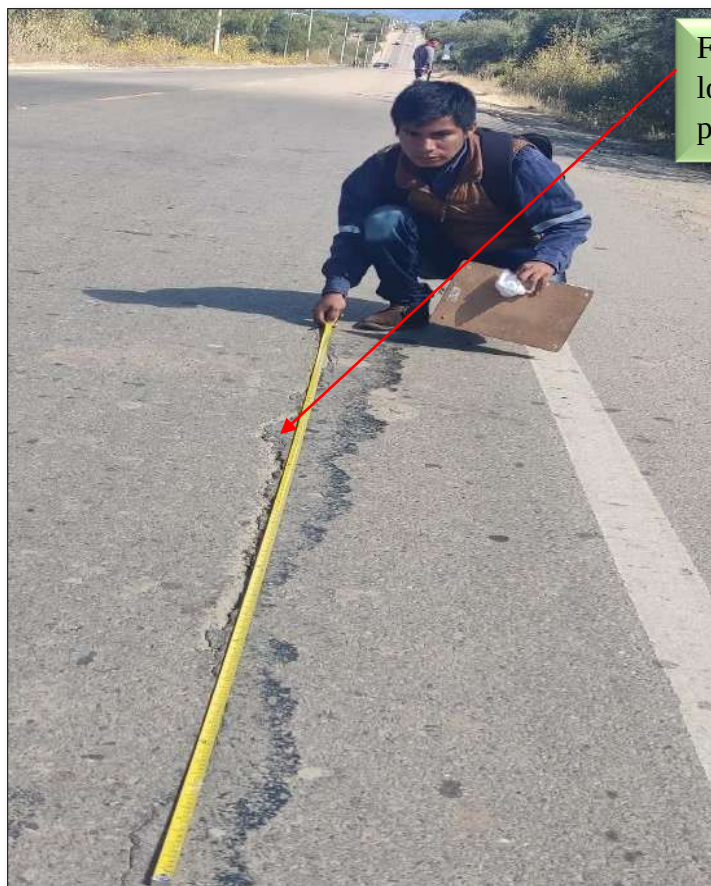
Falla por desnivel de berma en la progresiva 3+000
