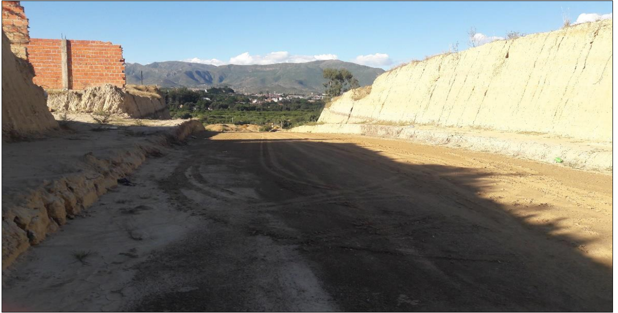
Material de sub rasante
