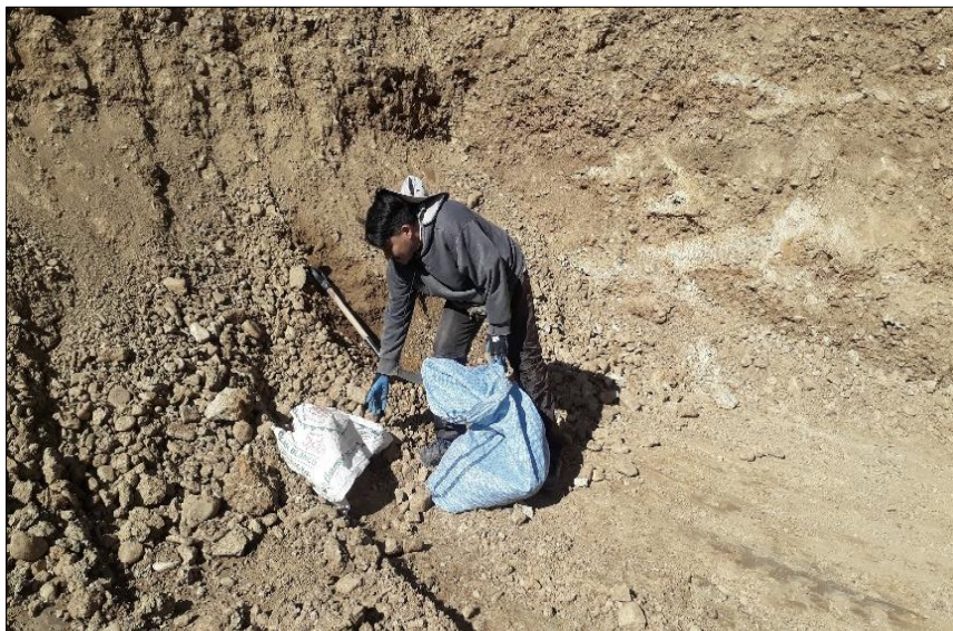
Toma de muestra para la sub base
